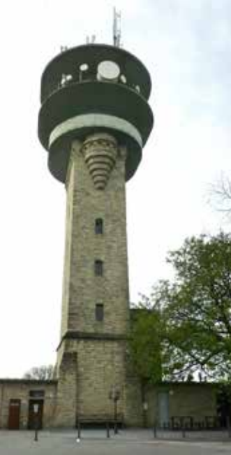
Eröffnung nach Turm- renovierung 2016
